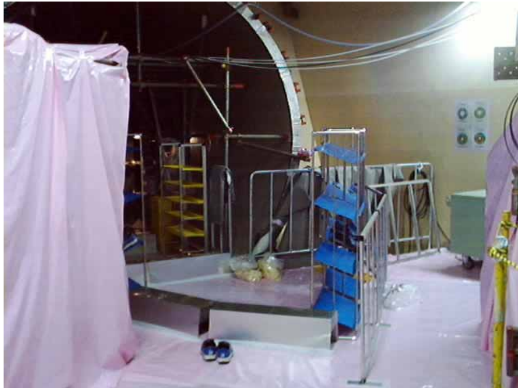
原子炉格納容器入口 ( B 2 区域用作業靴 ( 黄靴 ) 履き替え所 )
