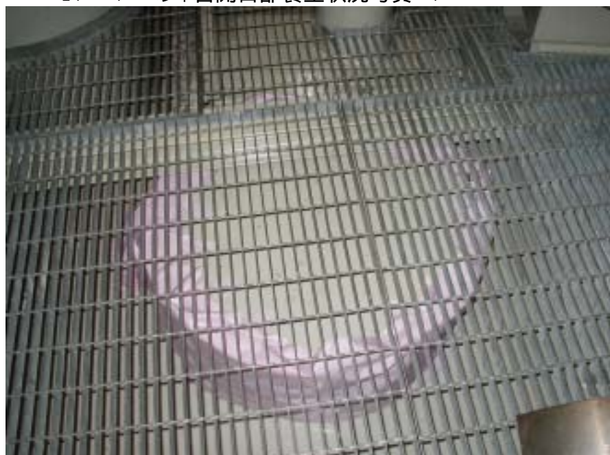
2F - 4 ベント管開口部養生状況写真 1
