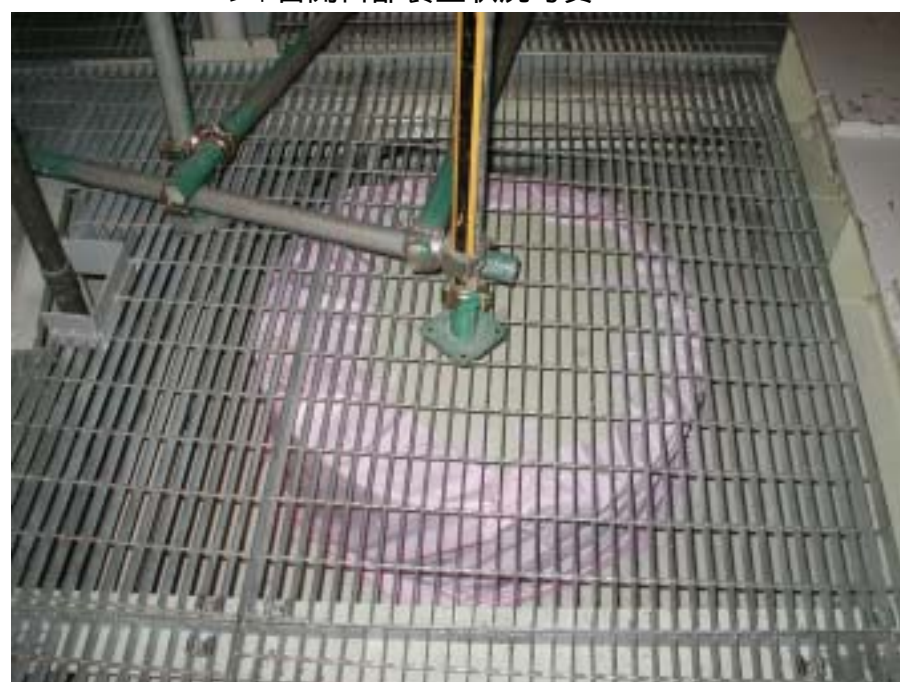
2F - 4 ベント管開口部養生状況写真 2
