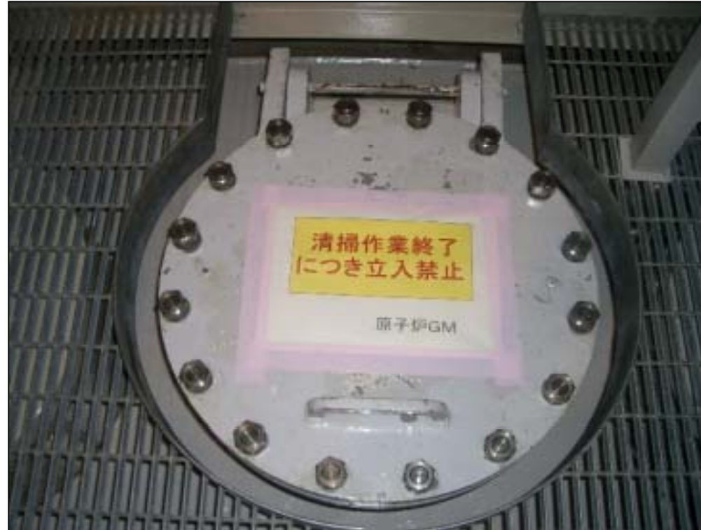
2F - 3 ドライウェル内マンホール *
