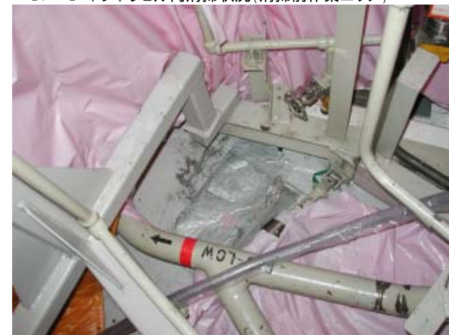
2F - 2 ドライウェル内清掃状況(清掃前作業エリア)
