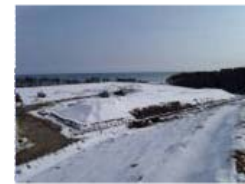
1 槽目の状況 (1/16撮影)
