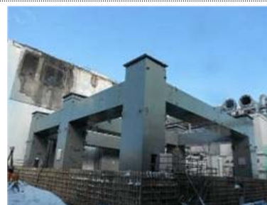
第1節部分鉄骨建方終了（1/14）
