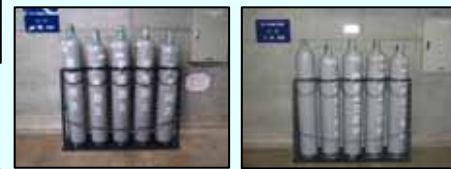
予備窒素ポンベを1プラントつきA系5本、B系5本配備 設置場所 1号機の例 原子炉建屋付属棟2階（非管理区域、T.P.12.8m）
