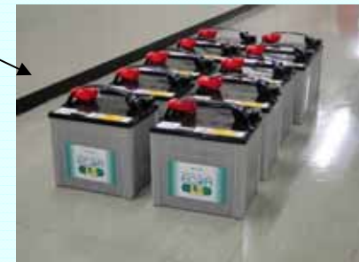
予備蓄電池 (12V×10台/1プラント) 保管場所：下部中央制御室(1号機)
