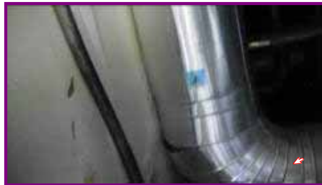
非常用復水器(A)凝縮水戻り配管
