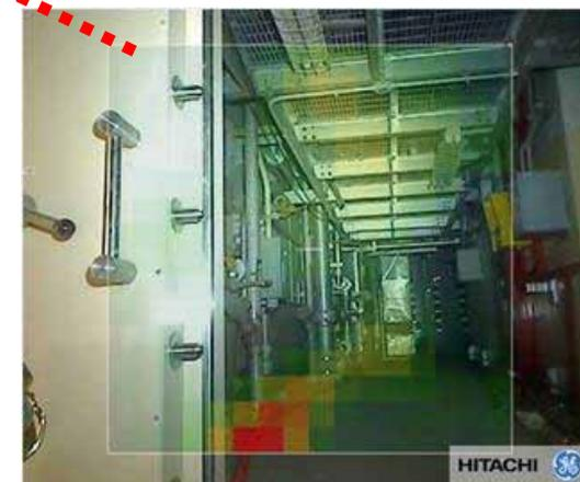
1号機原子炉建屋内線源/線量率調査
