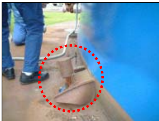
基礎ボルト，ブラケットの損傷
