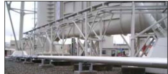
柏崎刈羽5号機周辺 消火配管の地上化
