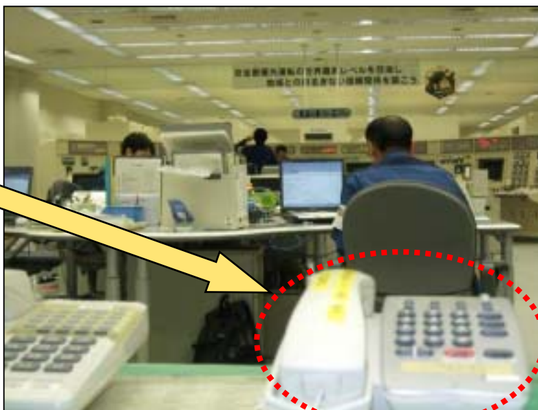
中央操作室内の専用回線 （自社電話回線網）
