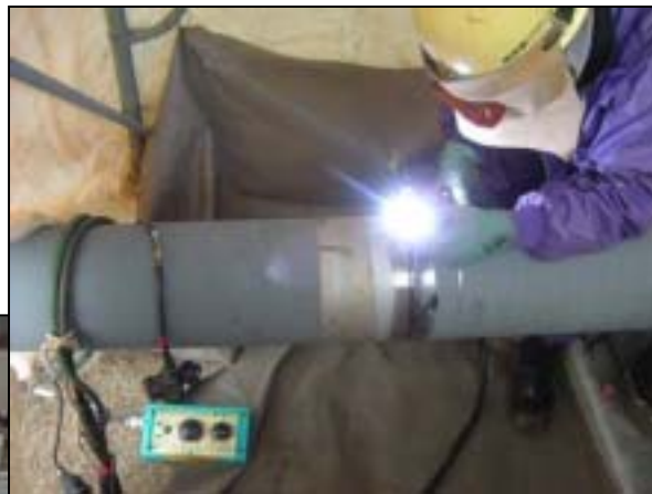
柏崎刈羽5号機周辺 消火配管の溶接化
