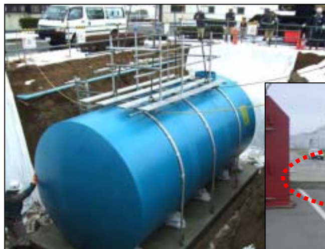
耐震防火水槽設置
