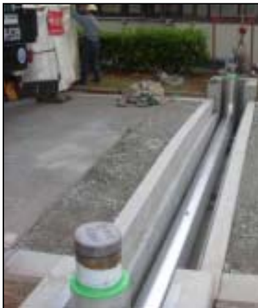
柏崎刈羽5号機周辺 消火配管のトレンチ化
