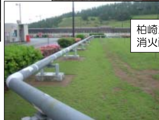
柏崎刈羽5号機周辺 消火配管の溶接化
