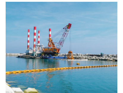
港湾工事状況
