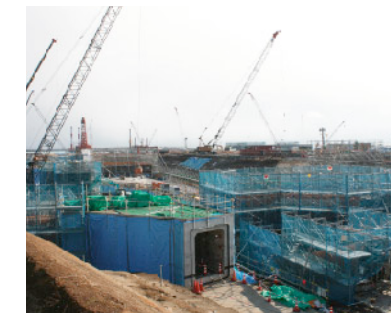
陸上工事状況
