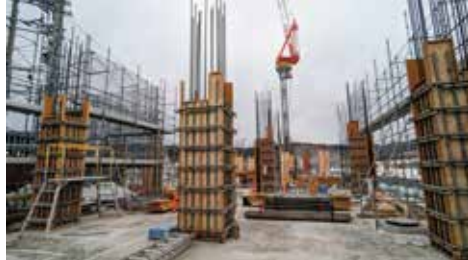
住居・交流施設棟工事現場
