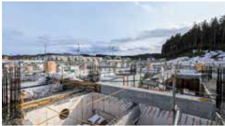
オフィス棟工事現場
