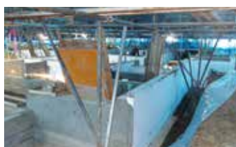
基礎工事の様子
