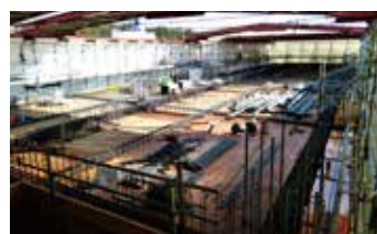
鉄筋工事の様子
