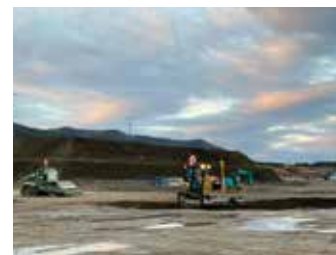
盛土造成の様子
