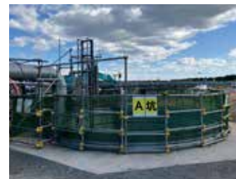
試掘坑入口(深さ約30m)
