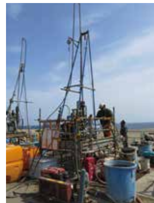
ボーリング調査(2022年4月撮影)
