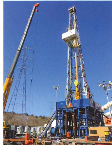
地震計設置工事(2021年3月撮影)
