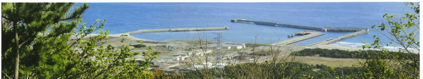
東通原子力発電所サイト全体(2021年10月撮影)
