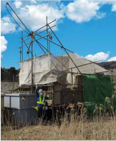
ボーリング調査(2021年4月)
