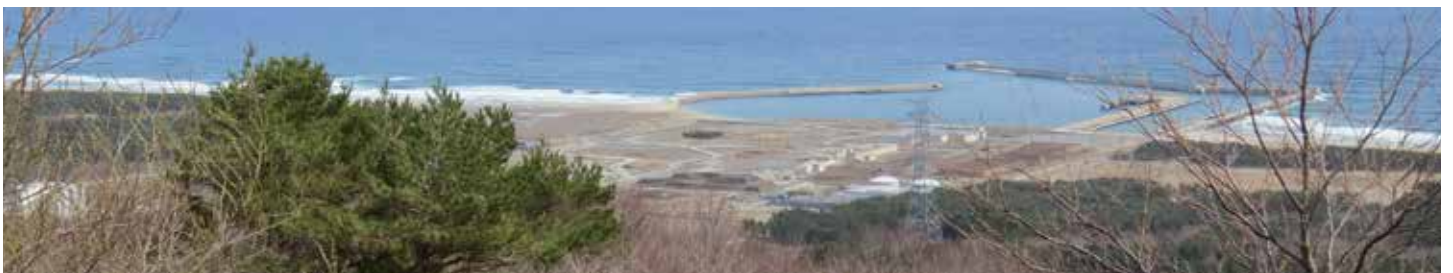
東通原子力発電所サイト全体(2021年4月)
