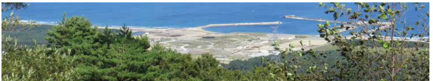
東通原子力発電所サイト全体(2020年9月撮影)
