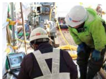
ボーリングコア ボアホール展開映像
