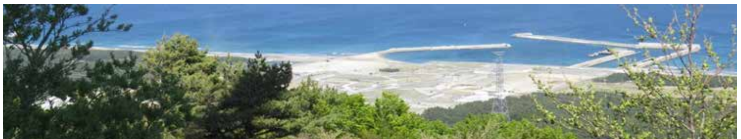
東通原子力発電所サイト全体(2020年5月撮影)
