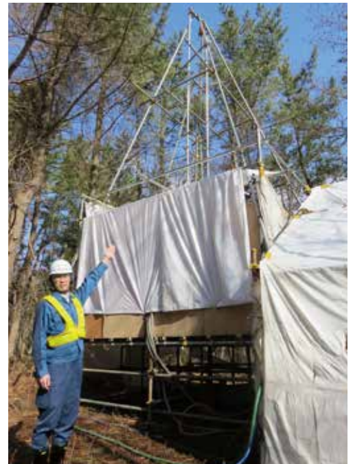
ボーリング調査(2020年3月撮影)
