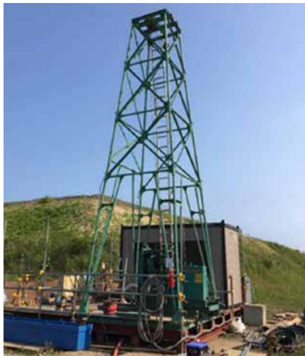
ボーリング調査の様子
