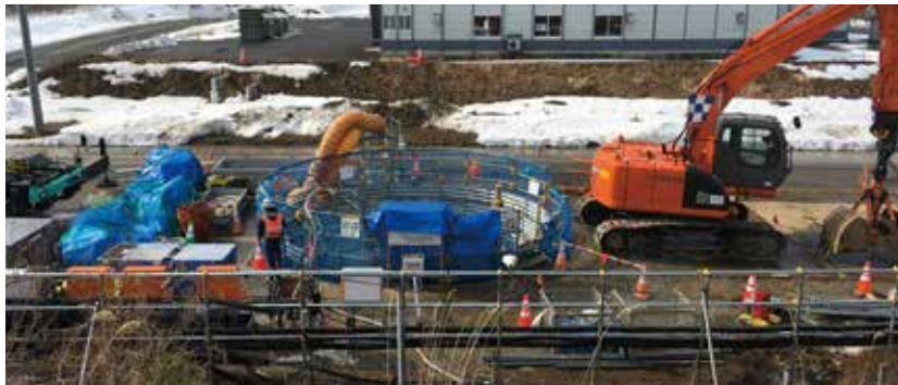
立坑掘削中の様子
