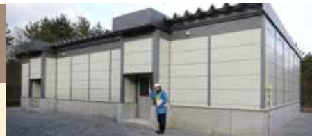
コア倉庫(外観)
