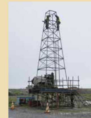
ボーリング調査の様子(陸側)
