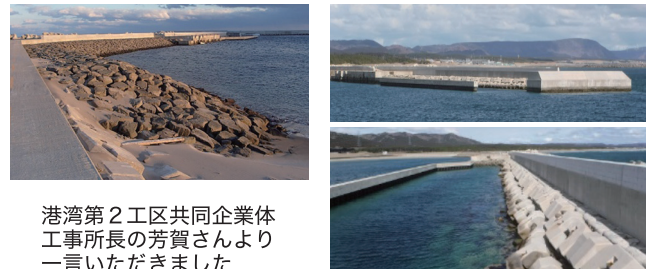
北防波堤完成写真
