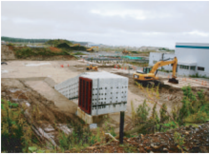
ダクト周辺埋戻作業
