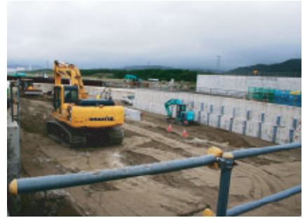
放水路周辺埋戻作業
