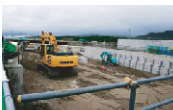
放水路周辺埋戻作業
