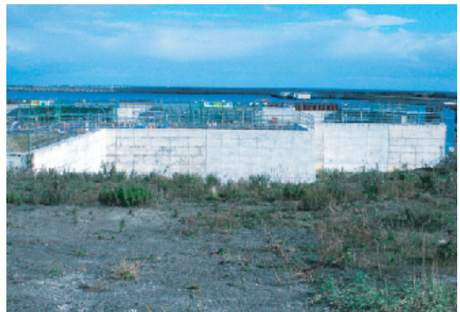
土留擁壁風景
