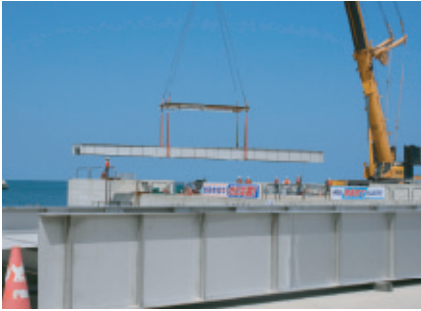
物揚場棧橋設置作業
