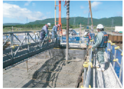
上部工コンクリート打設作業
