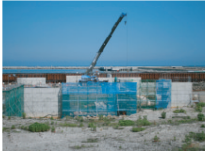
土留擁壁構築作業
