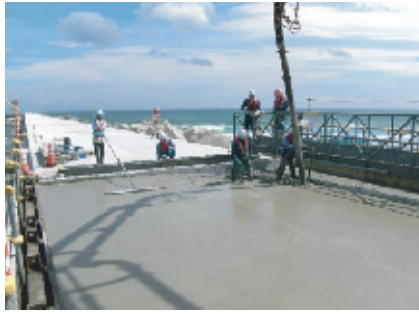
上部工コンクリート打設作業
