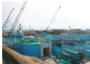
機械装置基礎工事状況
