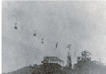
炭坑操業当時の石炭運搬の様子
