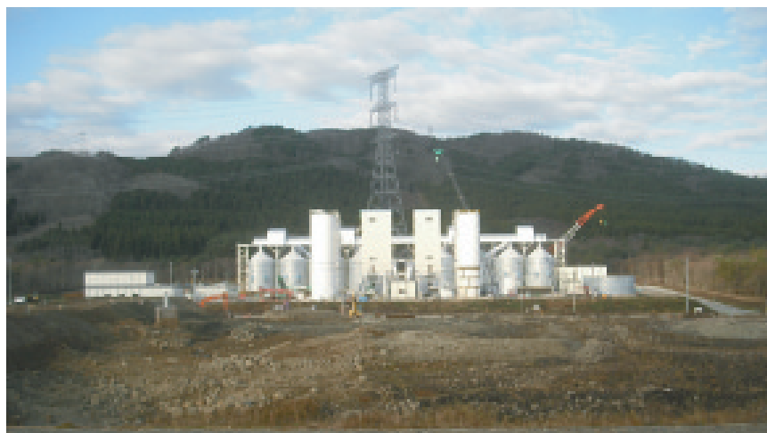
コンクリート製造設備の全景
