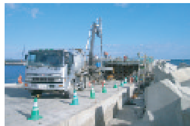
東防波堤工事状況
