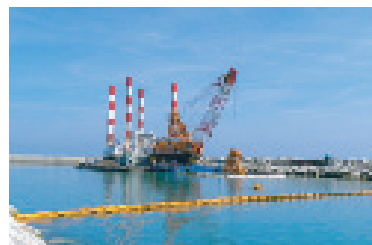
港内浚渫工事状況
