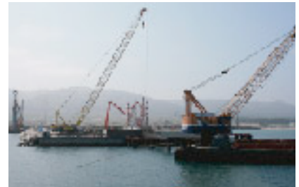
物揚場工事状況
