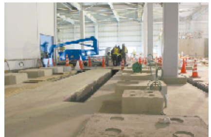
水処理建屋内工事状況
