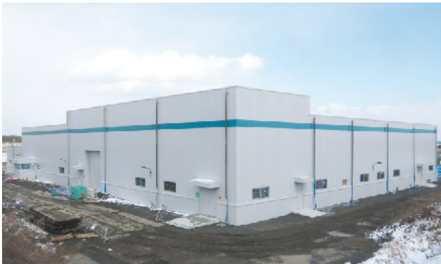
竣工した水処理建屋外観
