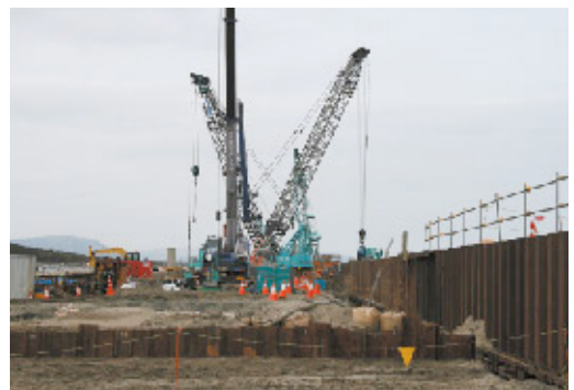
敷地護岸工事状況
