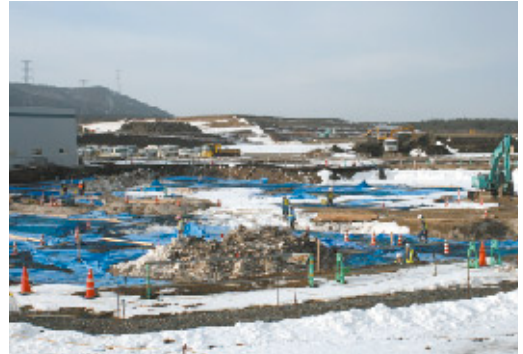
水処理設備基礎工事状況
