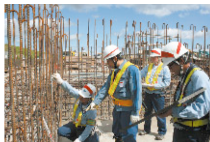
鉄筋の検査の様子
