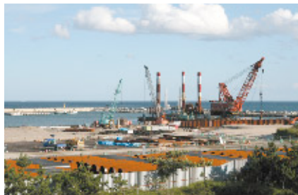
港内の浚渫の様子
