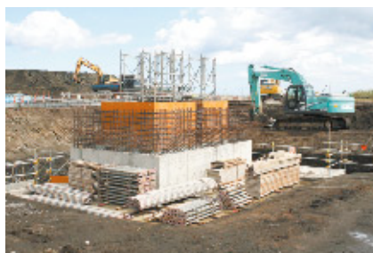
水処理建屋工事の状況
