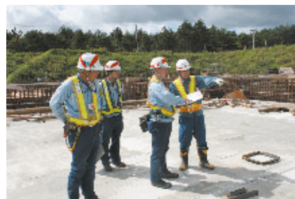
現場で作業員との打合せの様子
