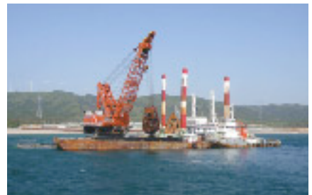
浚渫工事状況
