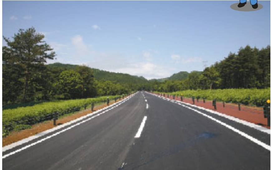
開通した進入路
