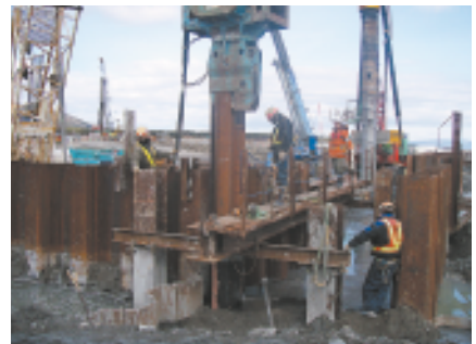
敷地護岸工事状況(矢板打ち込み)
