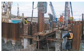
敷地護岸工事状況(矢板打ち込み)
