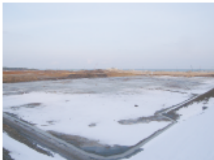
水処理建屋ヤード
