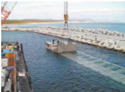
北防波堤工事状況(ブロック据え付け)
