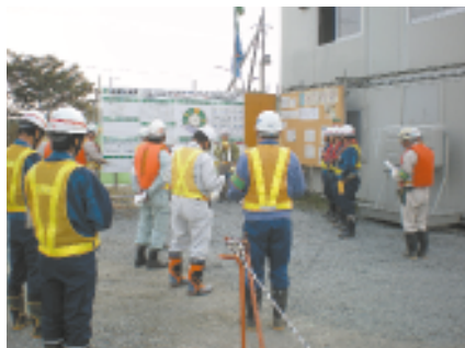
協力企業とともに作業手順と作業安全を確認
