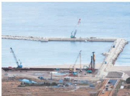
東防波堤・敷地護岸施工状況
