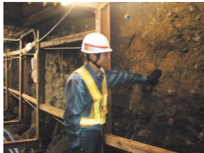
試掘坑で岩盤を確認する
