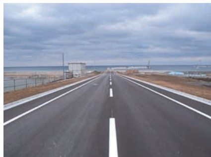
北側道路(H20.10月竣工)
