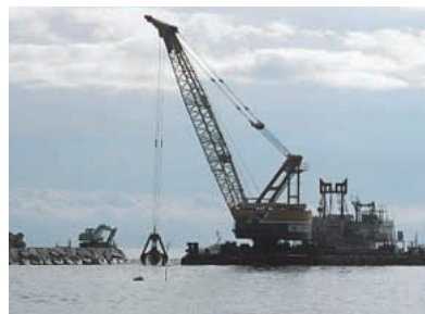
港湾工事状況
