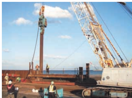
敷地護岸施工状況(矢板打ち込み)
