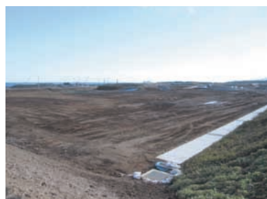
企業センターヤード敷地造成工事
