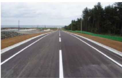
南側道路状況
