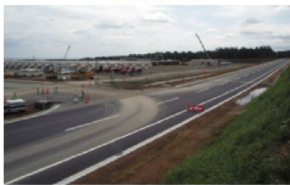
西側道路状況
