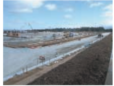
構内道路排水路工事状況
