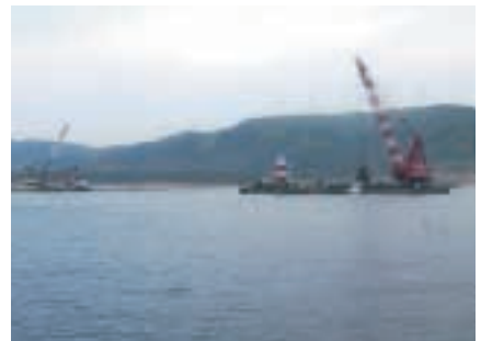
東防波堤施工状況
