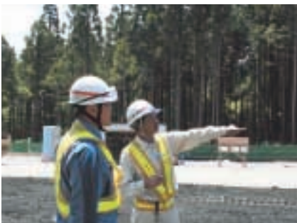
現場の工事進捗状況を確認(進入路付近)
