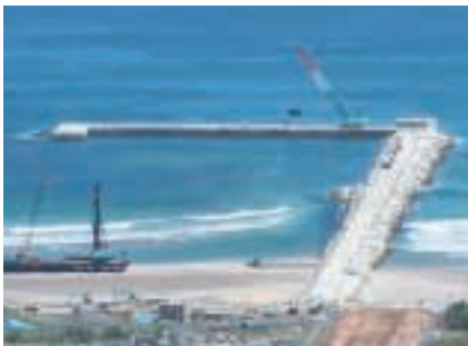
南防波堤施工状況
