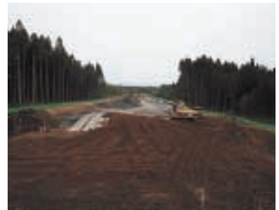
進入路工事状況(国道取付部)
