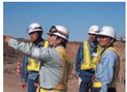
現場の工事進捗状況を確認(構内道路付近)
