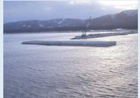
海域から見たケーソンと南防波堤
