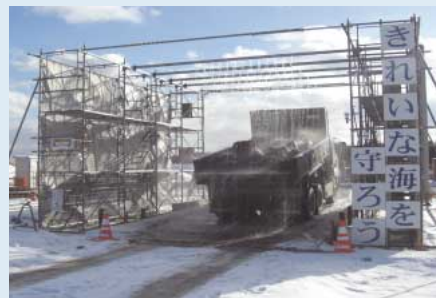
仮置き場での捨石洗浄状況
