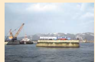
据付後のケーソン
