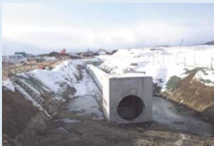
排水路構築状況
