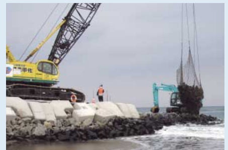
北防波堤施工状況
