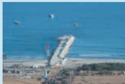
南側防波堤施工状況
