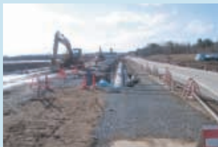
構内排水路構築状況
