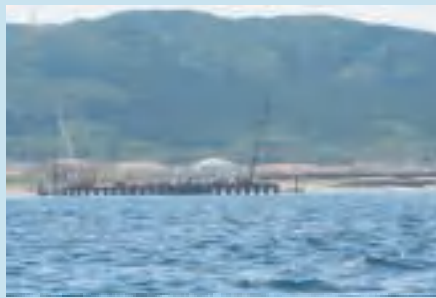
仮設栈台施工状況
