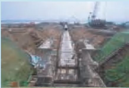
排水路構築状況
