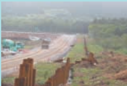
遮水壁打設状況
