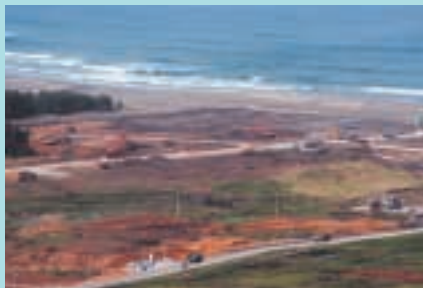
沈殿池造成状況
