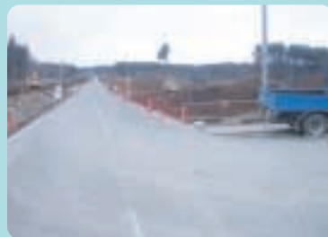
伐採後の様子
