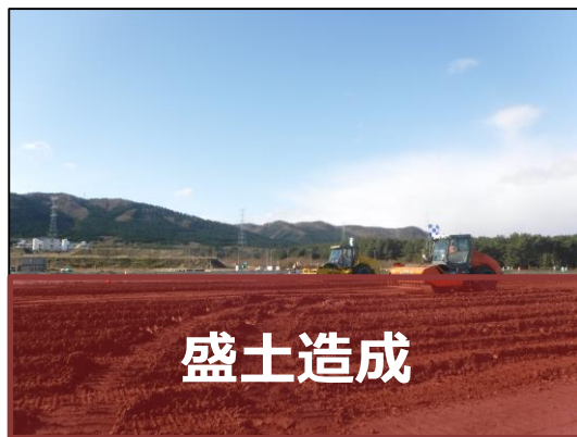
建設作業エリアの造成
