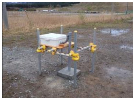
地下水位観測孔設置状況
