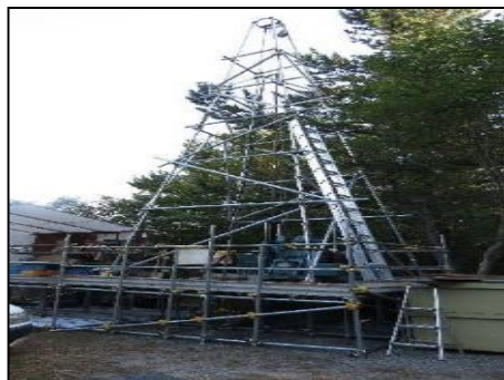
ボーリング調査
