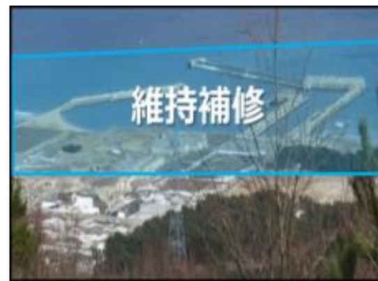
港湾設備の維持補修
