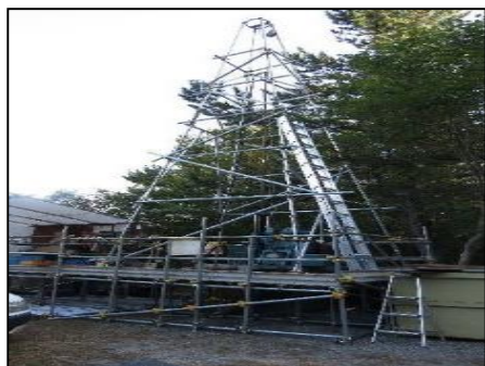
ボーリング調査
