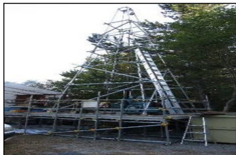
ボーリング調査
