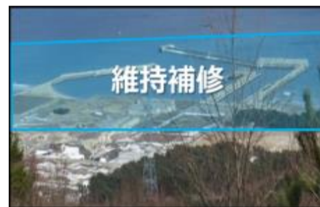
港湾設備の維持補修
