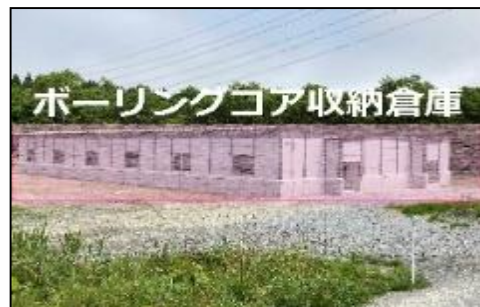
ボーリングコア収納倉庫の増設
