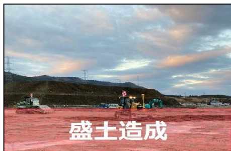
盛土造成 建設作業エリアの造成
