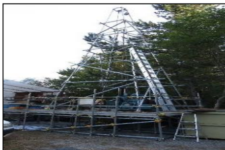
ボーリング調査
