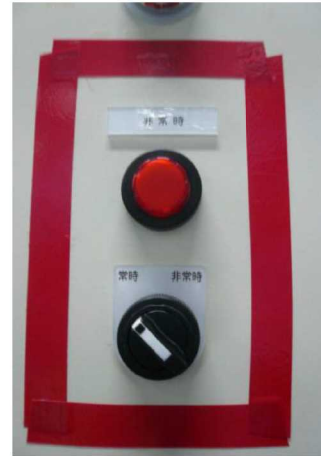
給排気隔離ダンパ（屋上）
