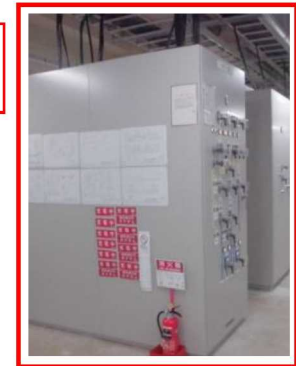
免震重要棟内緊急時対策所用ガ スタービン発電機用受電盤
