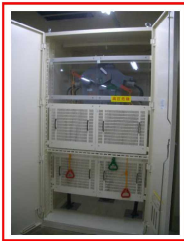
免震重要棟内緊急時対策所用ガスタービン発電機 —電源車切替断路器
