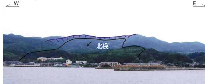
地すべりの全景写真 a
