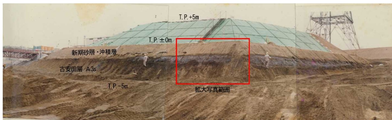
1号海水機器建屋南側法面 T.M.S.L. ±0~-5m全景 (地点②)
