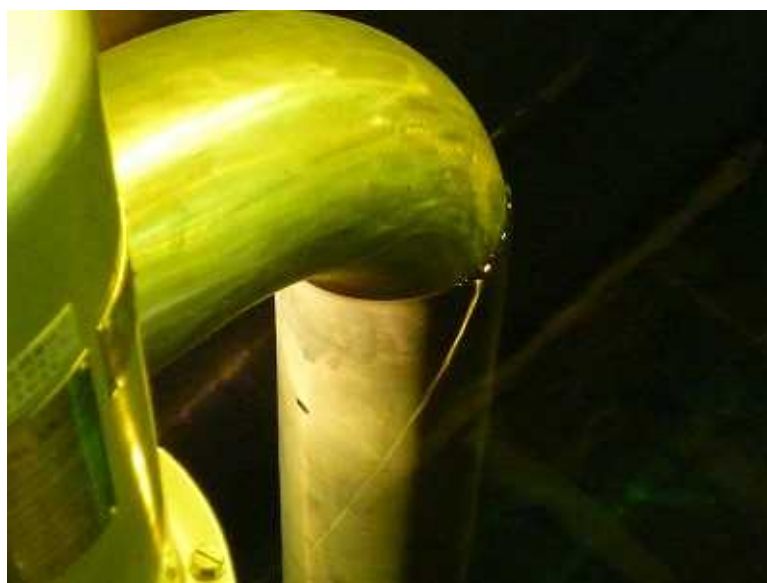
図4 サイフォンブレイク孔の設置状況
