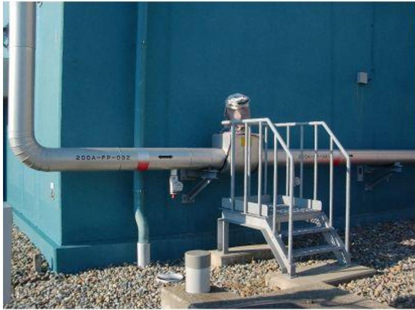
図 1-28 : 屋外消火配管への保温材設置状況
