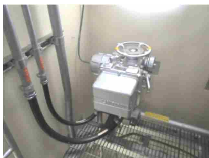
電動弁及び可とう電線管
