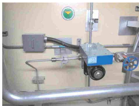
電磁弁及び可とう電線管
