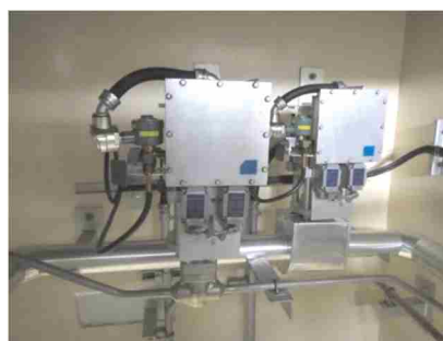
空気作動弁及び可とう電線管
