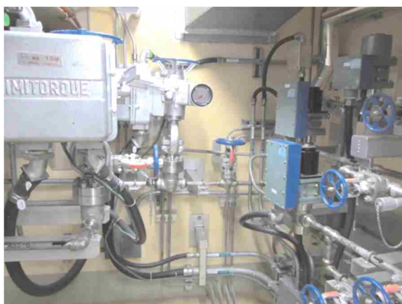
電動弁，電磁弁及び可とう電線管
