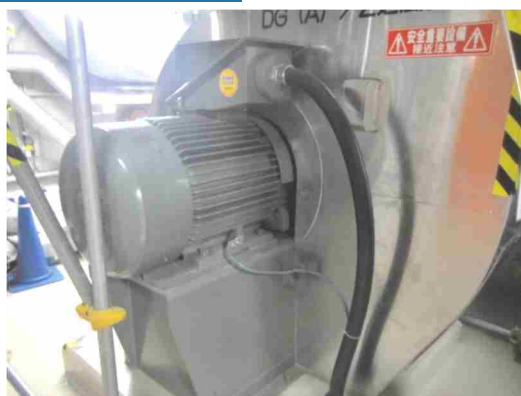
電動機及び可とう電線管
