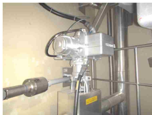
電動弁及び可とう電線管
