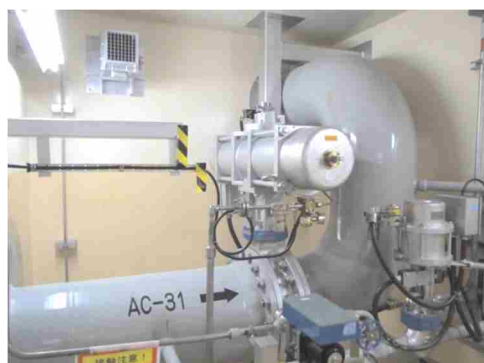
空気作動弁及び可とう電線管
