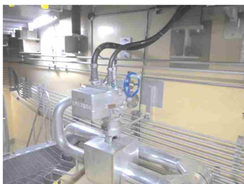
電動弁及び可とう電線管
