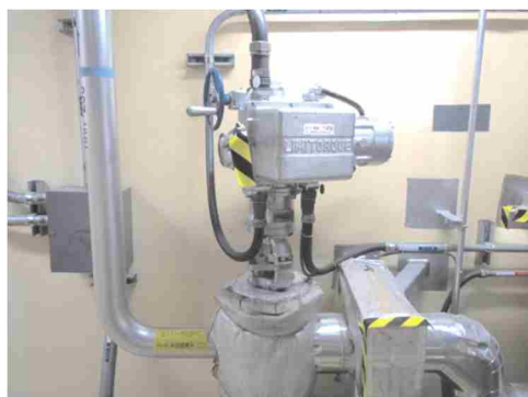
電動弁及び可とう電線管
