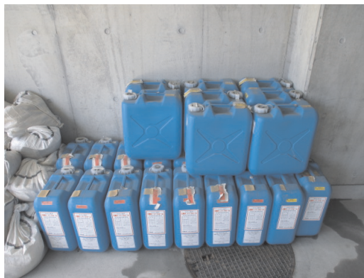
図4 泡消火薬剤ポリタンク 500 リットル
