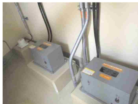
地震観測装置及び可とう電線管
