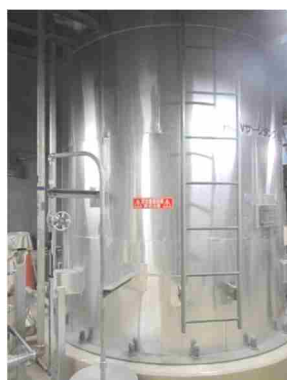
サージタンク
