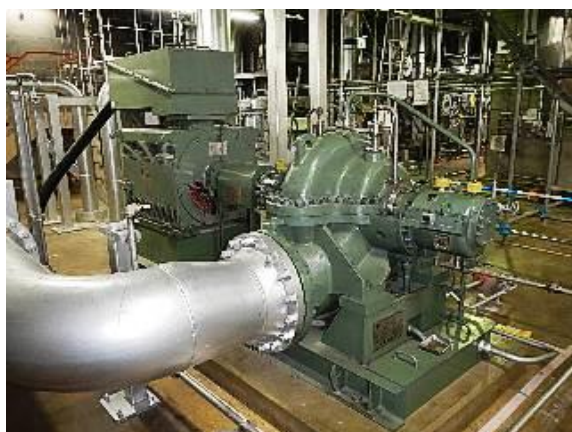
ポンプ、配管、支持構造物の例
