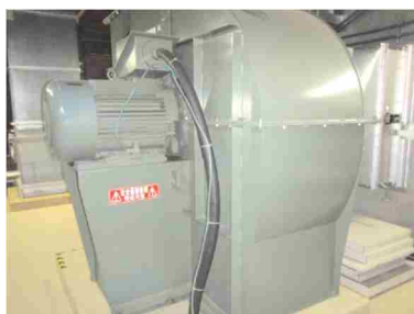
電動機及び可とう電線管
