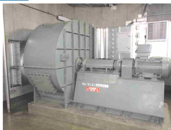
送風機及び電動機
