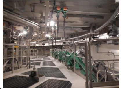
MSIV 内側隔離弁 (潤滑油)
