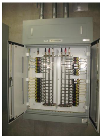
配線用遮断器の例 (ブレーカー)
