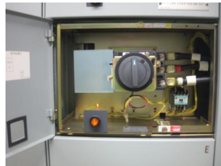
配線用遮断器の例 (MCC)
