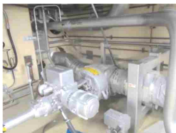
電動弁及び可とう電線管
