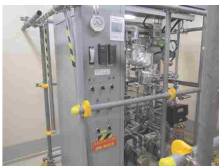
計装ラック及びサンプルポンプ
