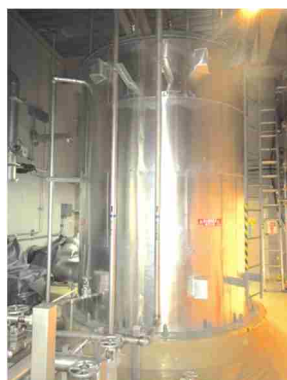
サージタンク
