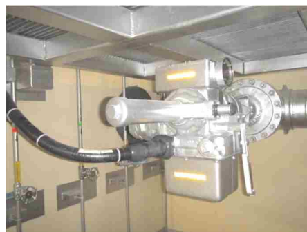
電動弁及び可とう電線管
