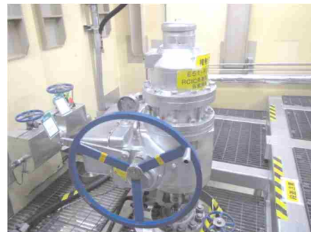
電動弁及び可とう電線管
