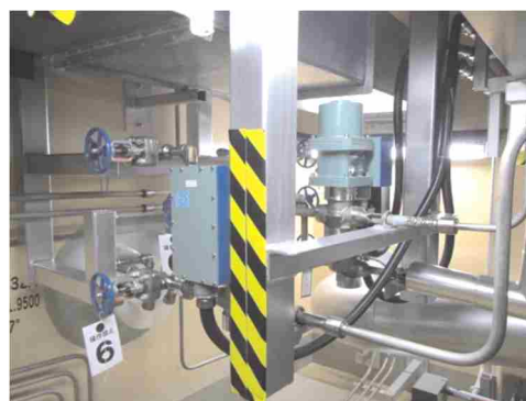
電磁弁及び可とう電線管
