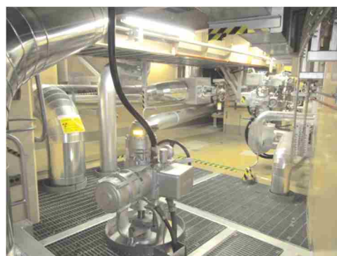
電動弁及び可とう電線管
