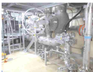
電動弁及び可とう電線管
