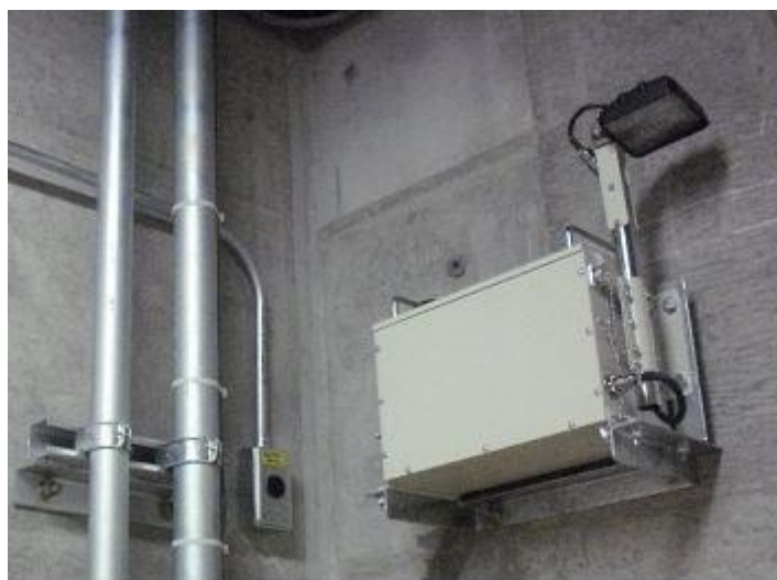
図1-26：消火用非常照明の設置例
