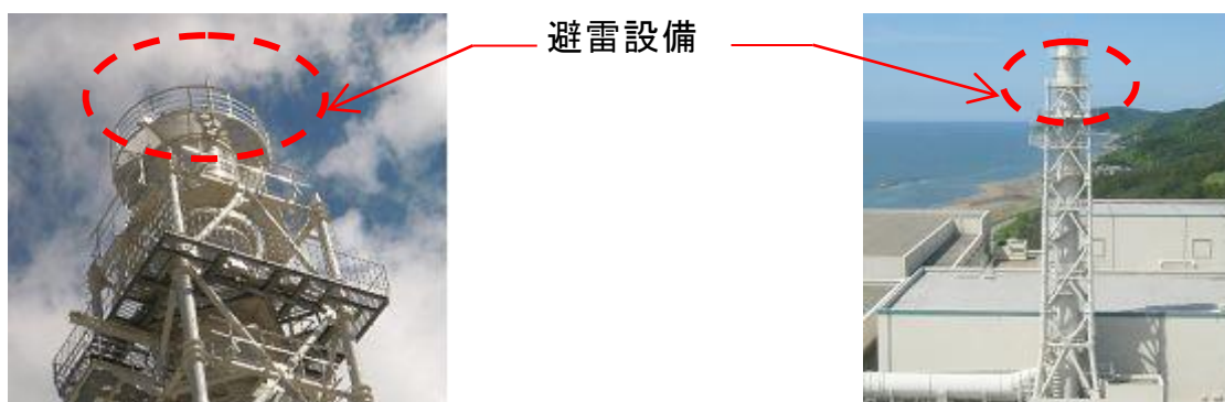
図 1-15：避雷設備の設置例（排気筒）
