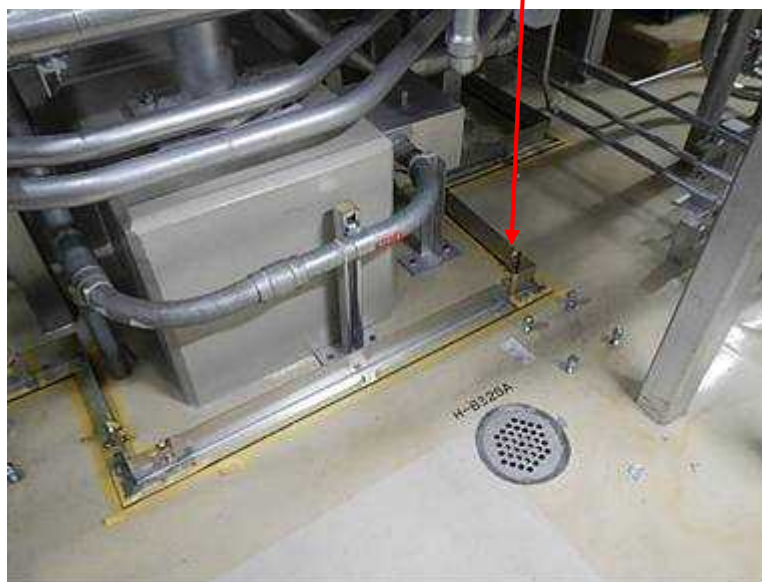
図 1 : 堰の設置状況
