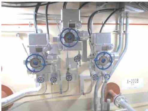
電動弁及び可とう電線管
