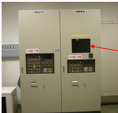
<火災受信機盤・防災盤>
