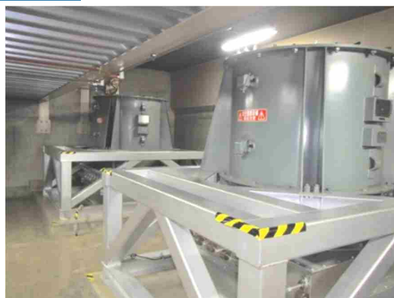
非常用送風機
