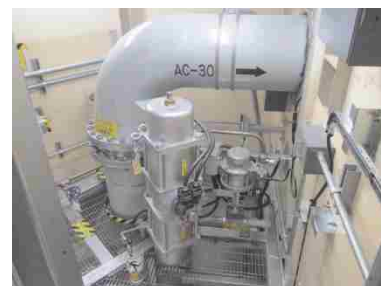
空気作動弁及び可とう電線管
