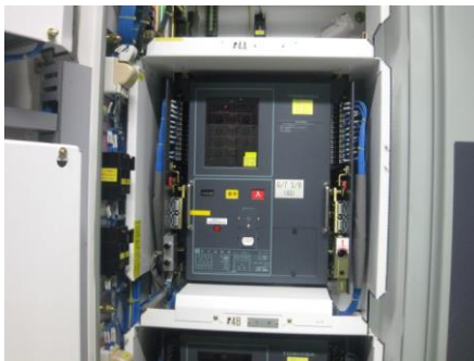
気中遮断器の例 (P/C)
