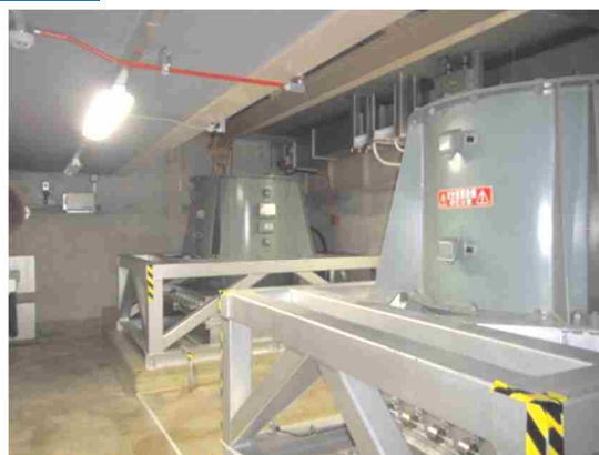
非常用送風機
