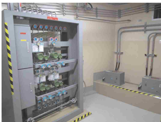
計装ラック及び地震観測装置
