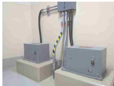
地震観測装置及び可とう電線管
