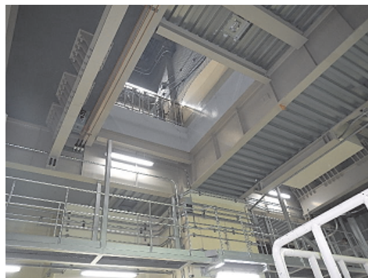
図 2-3 7号炉原子炉建屋 地下1階 機器ハッチの状況
