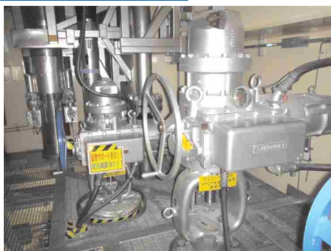
電動弁及び可とう電線管
