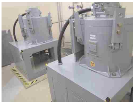
放射線モニタ及び可とう電線管
