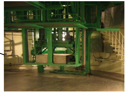
RIP・CRD 取扱装置 (潤滑油・グリス)
