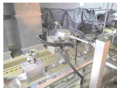
空気作動弁及び可とう電線管
