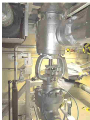
電動弁及び可とう電線管
