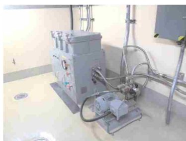
ダストサンプラ 及び可とう電線管
