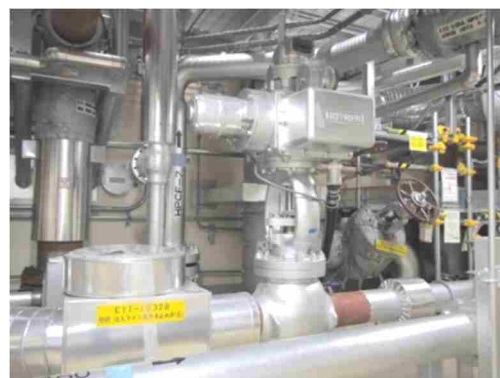
電動弁及び可とう電線管
