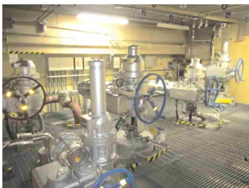
電動弁及び可とう電線管
