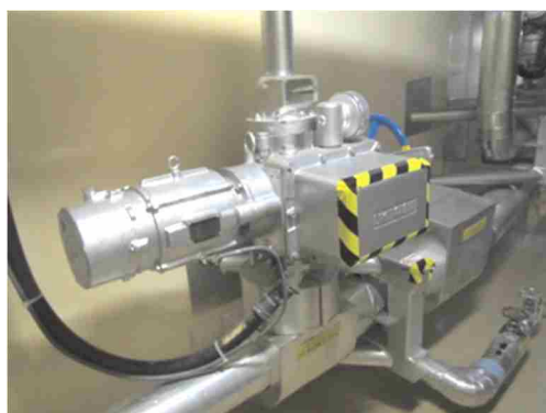
電動弁及び可とう電線管
