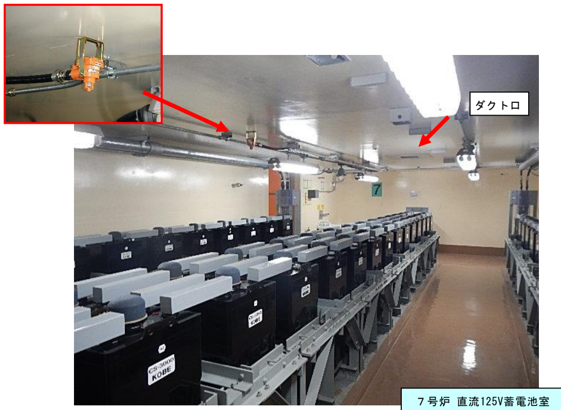
図 1-6 : 蓄電池室内の水素検出器設置状況
