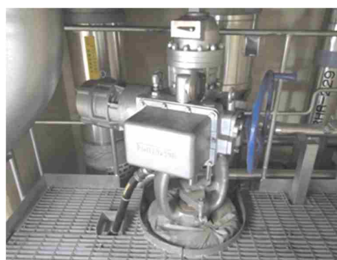
電動弁及び可とう電線管
