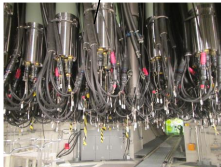
格納容器下部ケーブル
