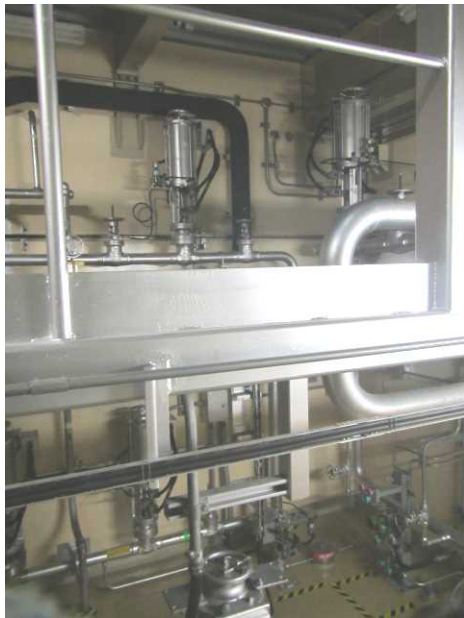
HCW 放出ラインのバルブの配置 (HCW バルブ室)
