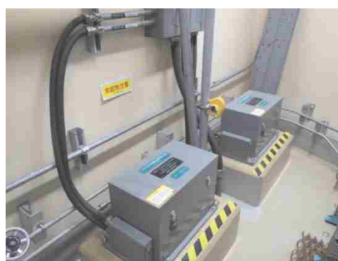
地震観測装置及び可とう電線管
