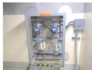
計器（圧力検出器）
