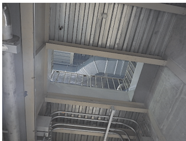
図 2-2 7号炉原子炉建屋 地下2階 機器ハッチの状況
