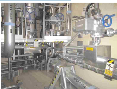
電動弁及び可とう電線管
