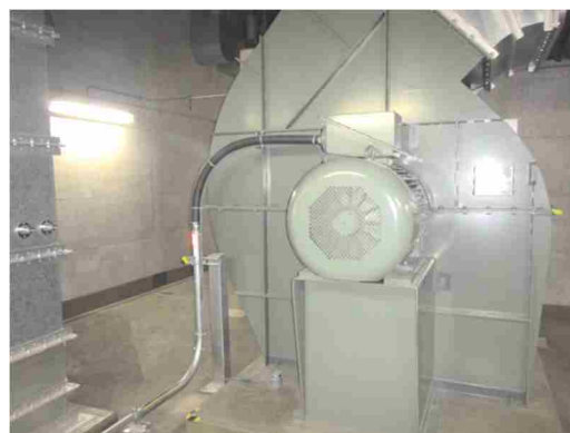
送風機，電動機及び可とう電線管
