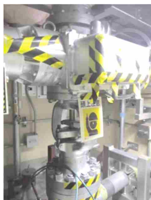
電動弁及び可とう電線管
