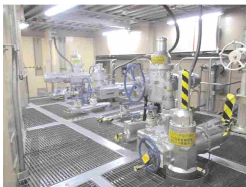
電動弁及び可とう電線管
