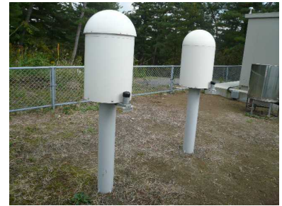
モニタリングポスト設置状況
