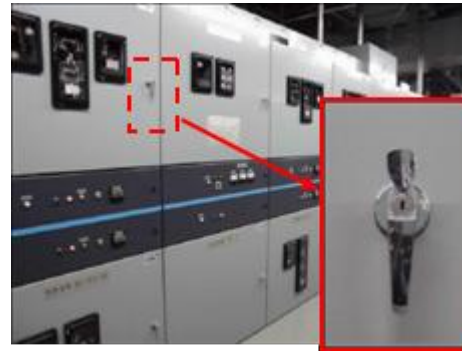
電源盤の施錠
