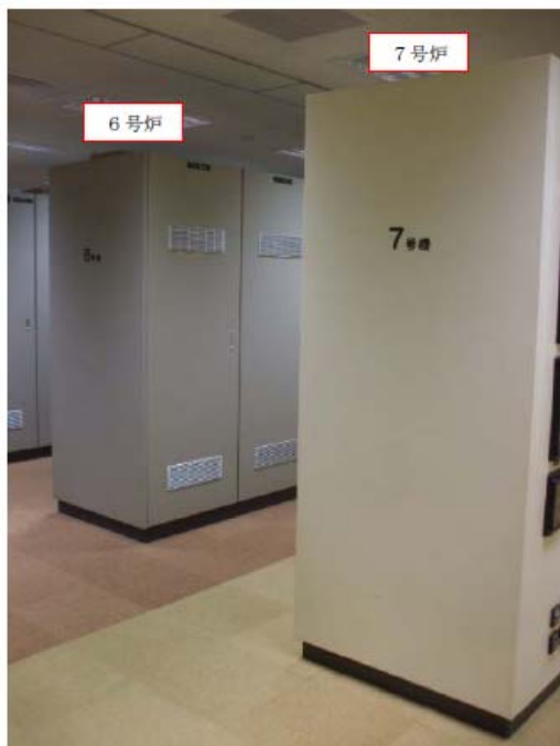
第 2.2.5-2 図 制御盤（裏盤）の色別管理
