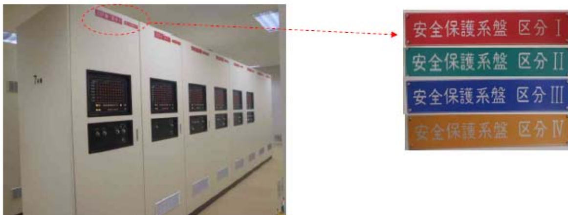
第 2.2.5-1 図 制御盤の銘板管理（安全保護系盤の例）
