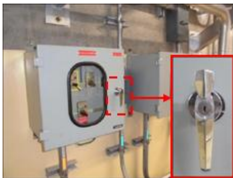
制御盤の施錠
