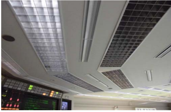
中央制御室照明
