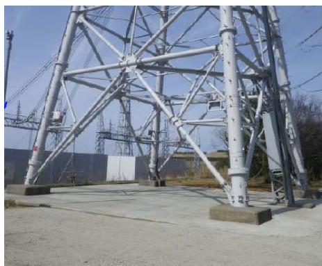
新新潟幹線 No. 1 送電鉄塔
