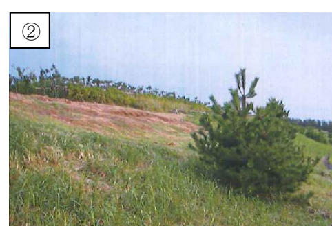
② 大湊側高台保管場所西側斜面（近景）
