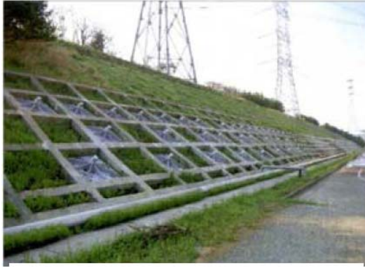
超高圧開閉所東側法面
