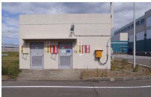
発電機用水素ガスボンベ建屋（6号炉）
