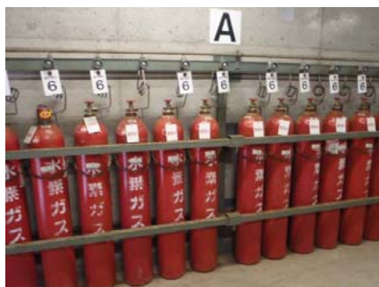
水素ボンベの固縛状況（6号炉）
