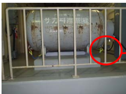
雑固体廃棄物焼却設備プロパン庫
