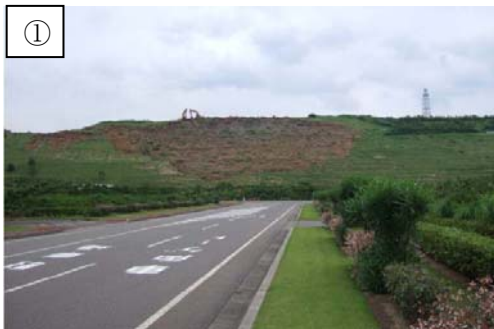
① 土捨場北側斜面（遠景）
