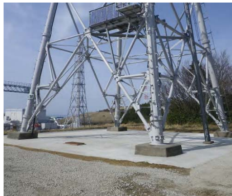
南新潟幹線 No. 1 送電鉄塔
