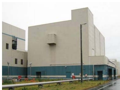
雑固体廃棄物焼却設備建屋（大湊側）
