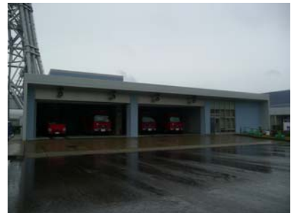
自衛消防隊（消防車隊）建屋
