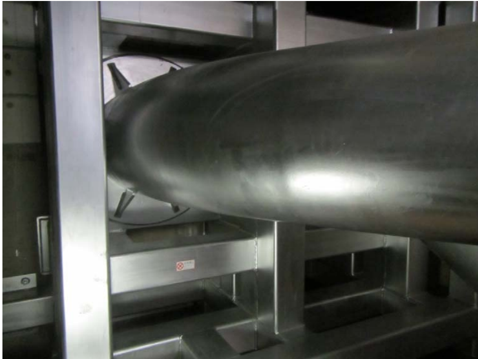
RCW 配管 外観
