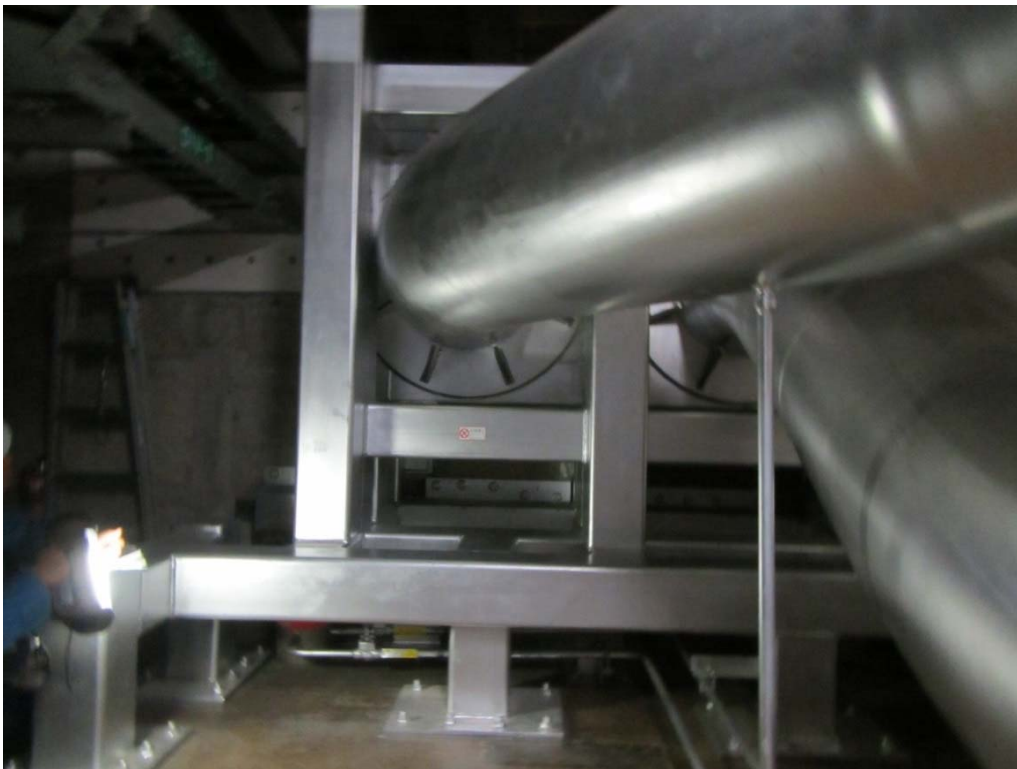
RCW 配管 外観
