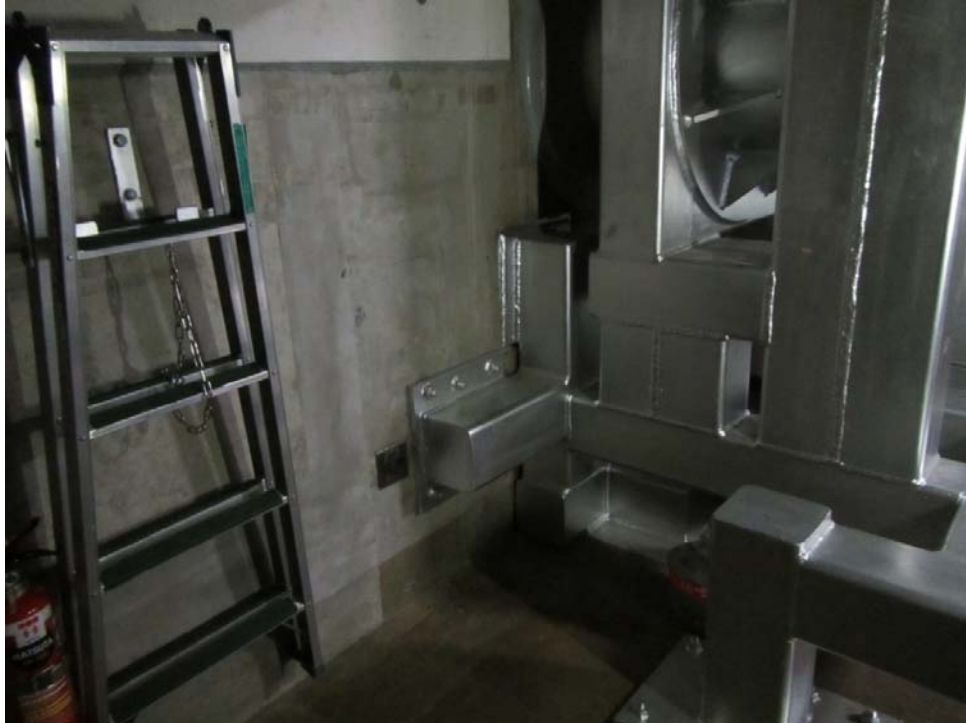
RCW 配管サポート 外観
