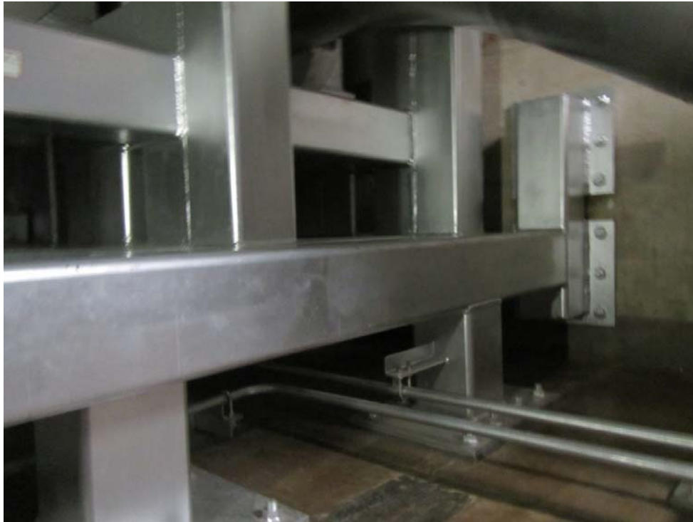
RCW 配管サポート 外観
