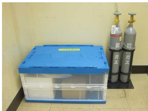
空気作動弁強制操作用の資機材配備(福島第二) (圧縮空気ボンベ, 接続用ホース, 接続部品等)
