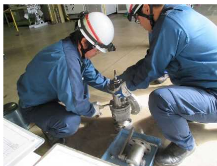
直営による安全弁の分解点検
