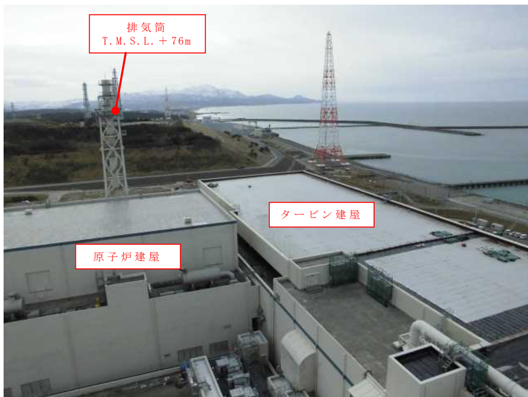
第 4.3-2 図 津波監視カメラ設置位置
